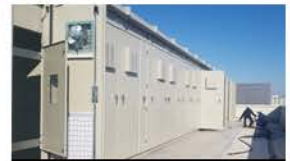
전기실 큐비를 작업시
